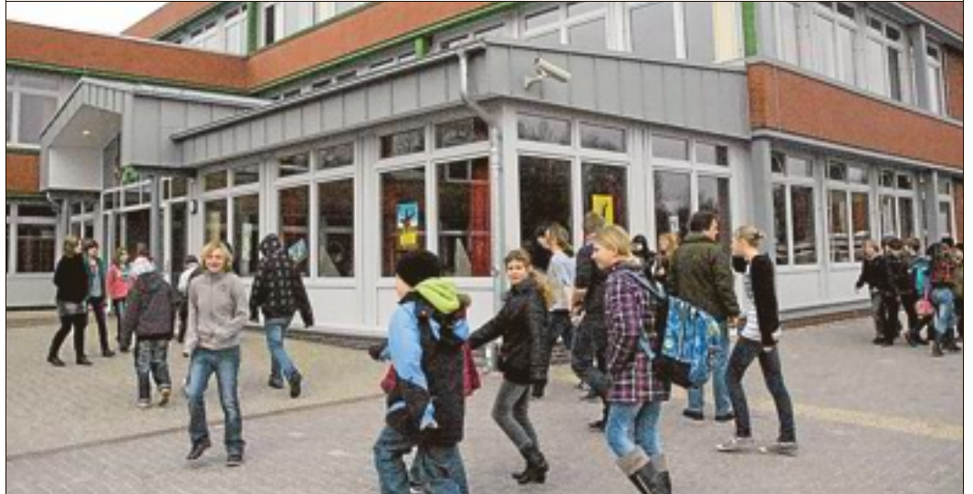
Die neue ebenerdig zugängliche Bücherei befindet sich seit verganginem Jahr gleich neben dem Haupteingang im Erdgeschoss der Schule „Altes Amt Friedeburg“.
