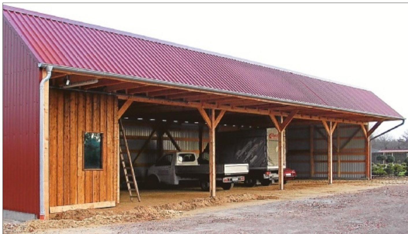
Bei dieser Remise stellt die Holzhandlung ihre Leistungsstärke unter Beweis.
