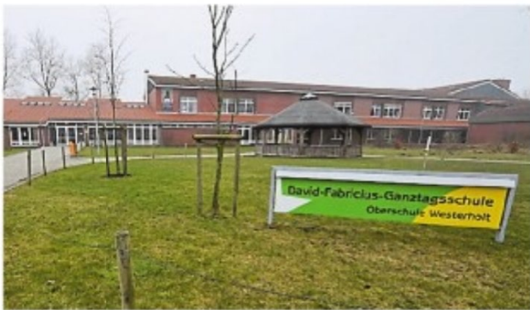
Die Bushaltestelle der David-Fabritius-Ganztagsschule Oberschule wird ab Montag umgebaut.
